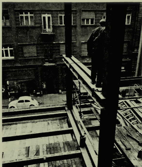
5. ábra. Az egyik ikertartó elhelyezve és ideiglenesen rögzítve
