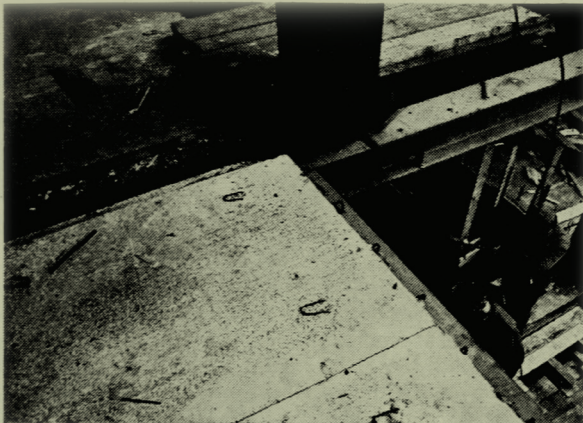
7. ábra. A panelek felfekvése a fiókbordára
