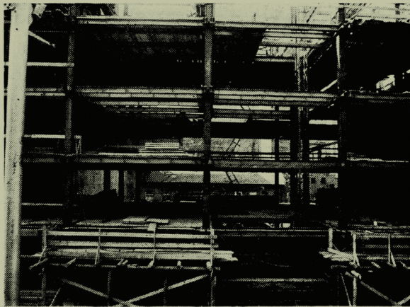
10. ábra. Az épülő irodaház acélváza az utca felől nézve
