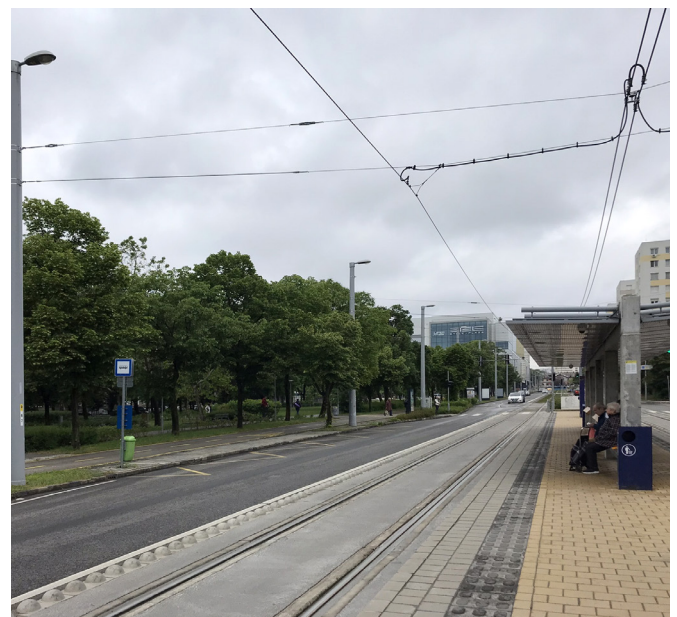
2. ÁBRA: Peron melletti pályakialakítás kiöntött síncsatornás felépítménnyel a budapesti 1-es villamos vonalán (SzÁ)
