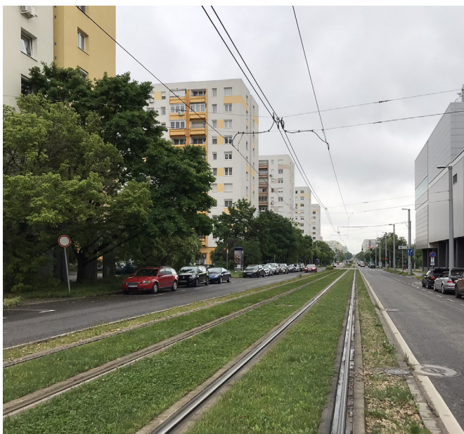
1. ÁBRA: Hosszgerendában kialakított kiöntött síncsatornás felépítmény mint „füves” vágány a budapesti 1-es villamos vonalán (SzÁ)
