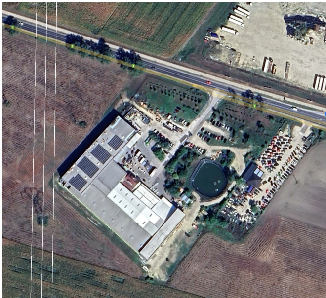
1. ÁBRA: A jelenleg is érvényes védőtávolság-előírások negligálása: 400kV-os légtávvezeték szélső szála a 2004-ben épült Győr, Bécsi úti ipari csarnoktól mindössze kb. 8 m-re, az előírt 28 m helyett [a szerző mérése, Google Earth [1]]
